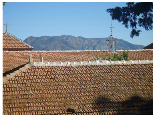
Le toit de la chapelle à rénover ; en fond le Tamesguida
